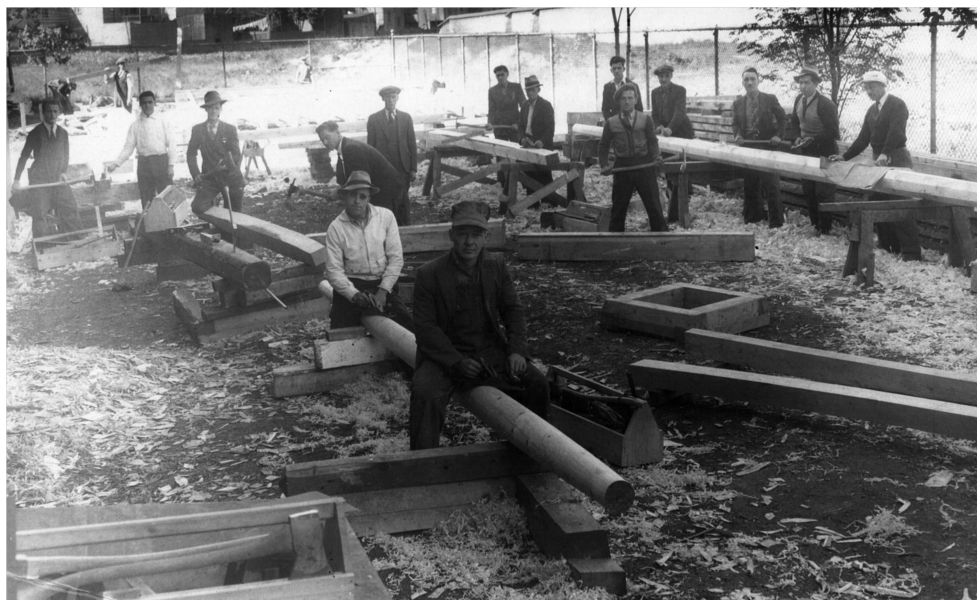
Chantier Davis, 1941. Le contremaître, Pierre-Ernest Beaulé, à l'extrême droite.
