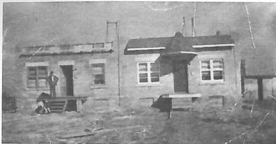
La construction d'un semi-détaché au 7347, rue Chabot en 1946
